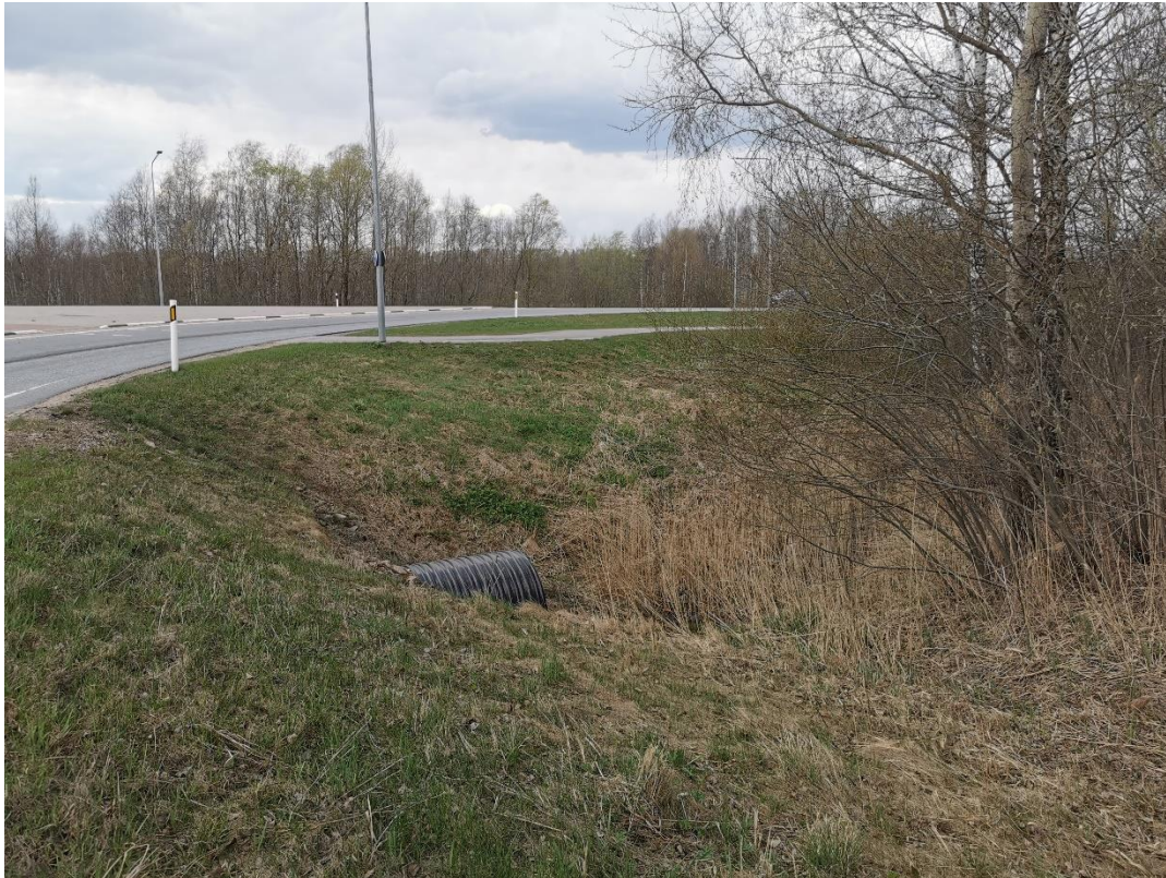
Foto: objekti algus, olemasolev truup D1500 teras
